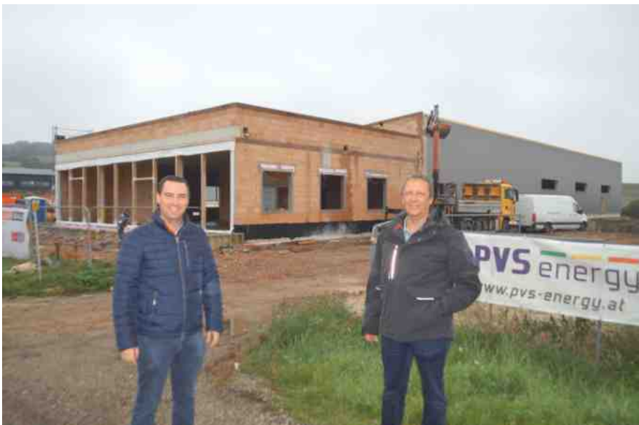
Foto: Bürgermeister Daniel Fröschl und Bald-Staatzbürger Anton Smolak besichtigen die Baustelle des neuen Firmengebäudes der Firma PVS Energy.
