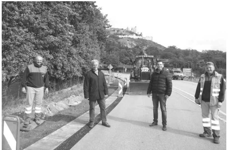
Foto: An der Ortsdurchfahrt von Staats-Kautendorf wird bereits wieder fleißig gearbeitet: Hermann Madner, Straßenmeister Josef Gartner, Bürgermeister Daniel Fröschl und Baustellen-Leiter Christian Schaffer.
